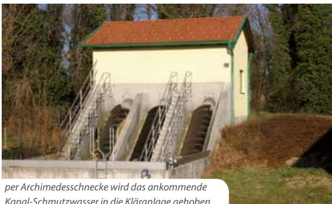
per Archimedesschnecke wird das ankommende Kanal-Schmutzwasser in die Kläranlage gehoben
