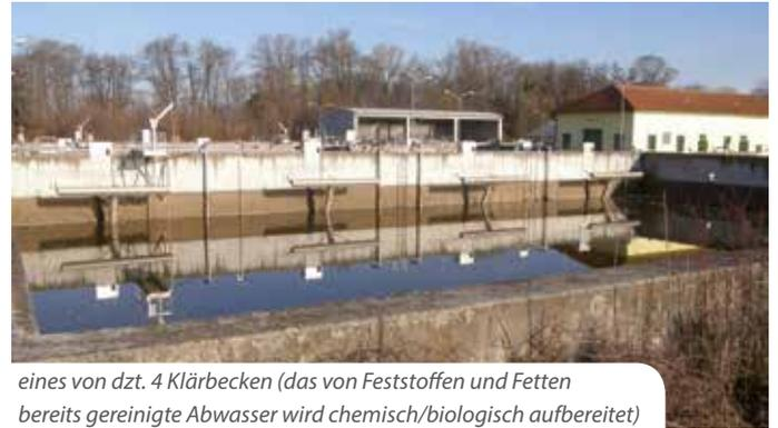
eines von dzt. 4 Klärbecken (das von Feststoffen und Fetten bereits gereinigte Abwasser wird chemisch/biologisch aufbereitet)
