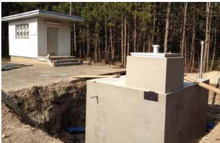
Beim Wasserwerk II am Triftweg wird eine Drucksteigerungsanlage gebaut, um das Gemeindegebiet Wöllersdorf über die leistungsstärkeren Brunnen III und IV (in Steinabrückl) versorgen zu können. Diese Brunnen sind auch an die Aktivkohleanlage angeschlossen. Die Inbetriebnahme wird in ca. drei bis vier Wochen erfolgen.
