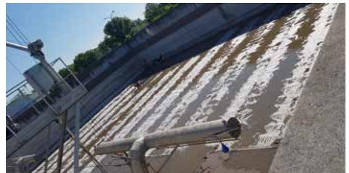
Bild von einem von vier Klärbecken zu je 45,5m x 35,5m --- Wasserstand maximal 5m – minimal 3,8m
