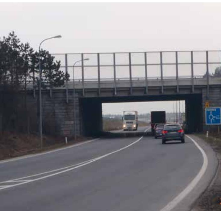
Während der gesamten Sanierungsmaßnahme ist je ein Fahrstreifen pro Richtung mit einer Breite von mindestens 3,25 m vorgesehen, so dass der Verkehr zwar langsamer aber trotzdem problemlos durch die Baustelle geleitet werden kann. Selbst während der Phase 2 - der Sanierung des Brückenmittelteils - werden zwei Fahrstreifen links und rechts der Gerüstinsel freigehalten, damit sowohl die Fahrt ins, als auch aus dem Piestingtal jederzeit möglich ist, ohne durch unser Ortsgebiet fahren zu müssen.
